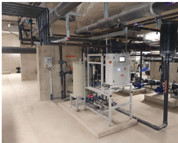
Solution de récupération des calories
