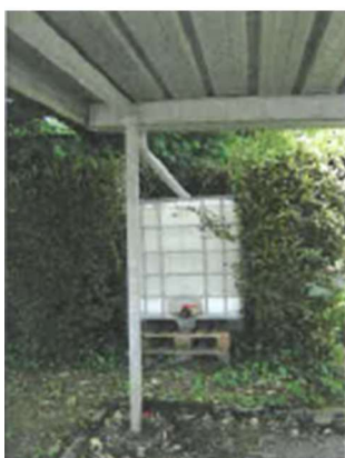
Cuves de récupération des eaux de toitures des abris à vélo et poulailler
