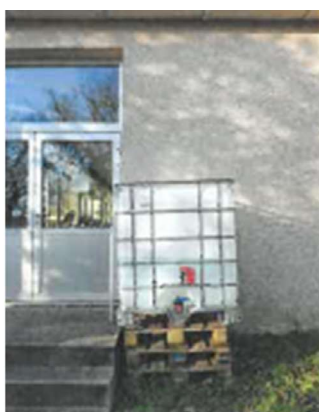
Cuve de récupération des eaux de cantine
